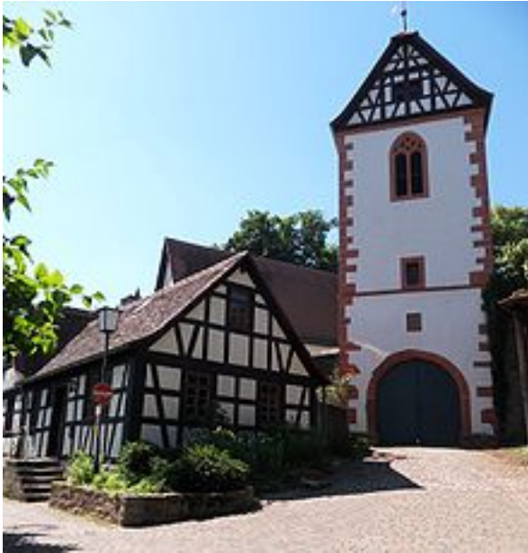
Tor- und Glockenturm der Wehrkirche, daneben das kleine Fachwerkhäuschen Pfarrberg 11
